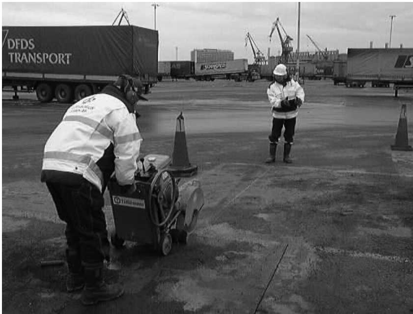
Asfaltskapning.
