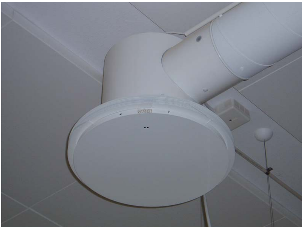
Bild 4 Närbild av ett don av typen IDCC.
