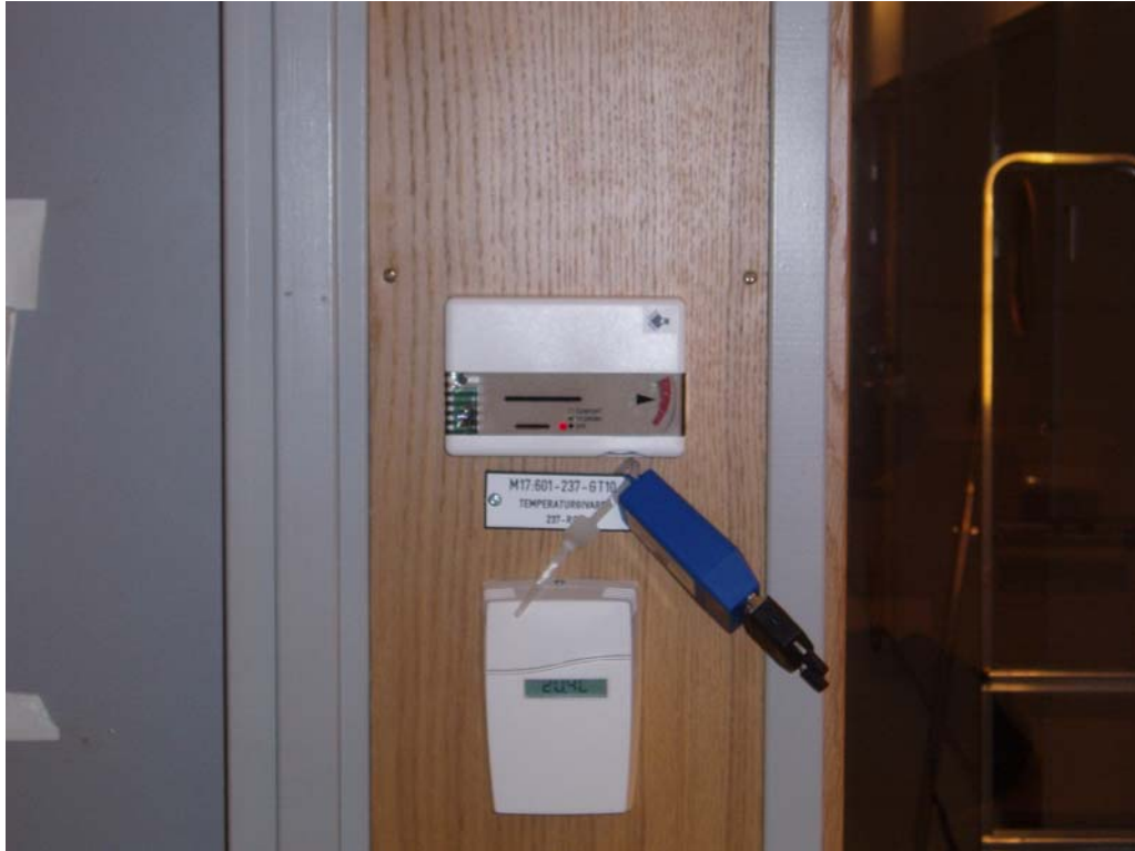
Bild 5 Styr- och reglerenhet (temperatur och koldioxid) för system e.r.i.c. i en större sal.
