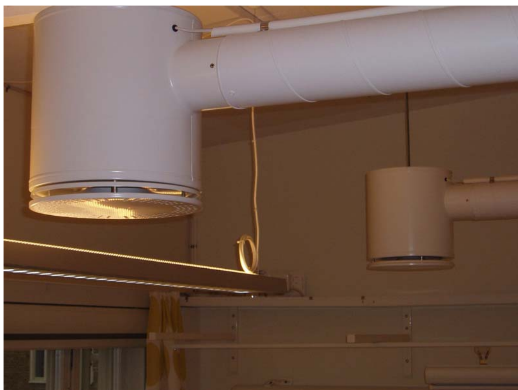
Bild 2 Närbild av ett don av typen e.r.i.c.
